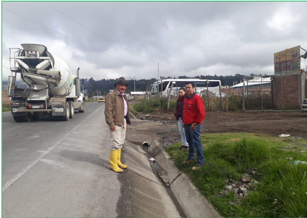
Ilustración 60. Verificación de acumulación de aguas lluvias en el alcantarillado
