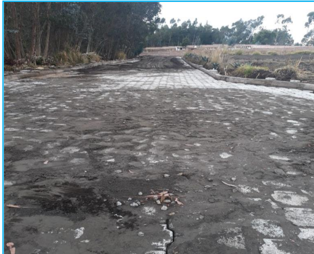
Ilustración 25. Trabajos de adoquinado San Vicente de Bayushi
