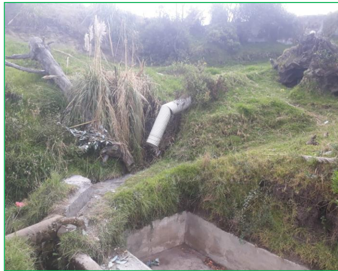
Ilustración 56. Recorrido para la ubicación del sitio para la planta de tratamiento
