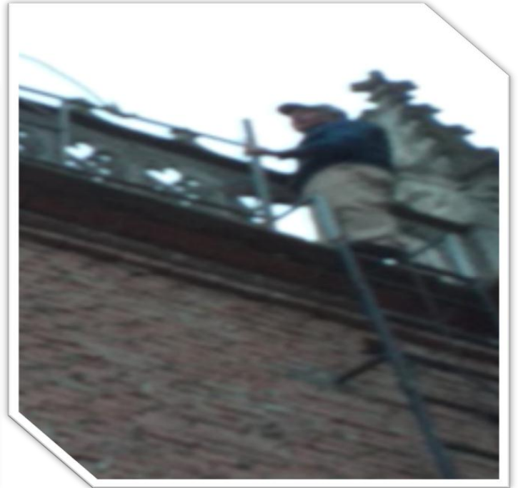
Ilustración 94. Descenso de andamios desde la torre de la Basílica Santiago de Calpi
