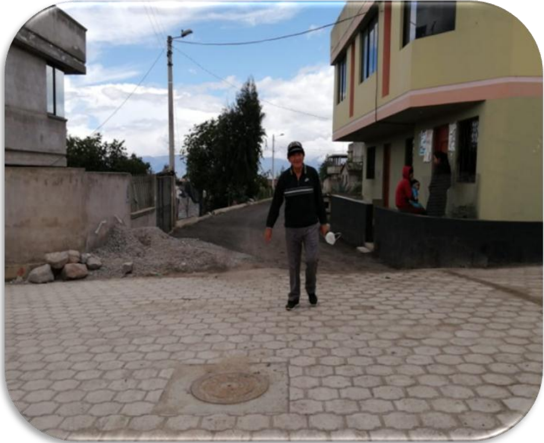
Ilustración 34. Recorrido por las Comunidades, verificación de obras.
